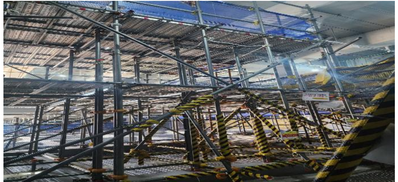
SK하이닉스 반도체 공사
