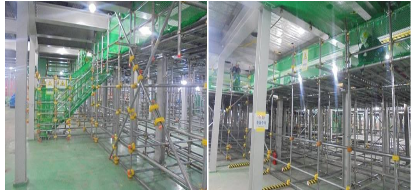
삼성물산 탕정8라인 아산FAB마감공사 2차 비계설치 공사
