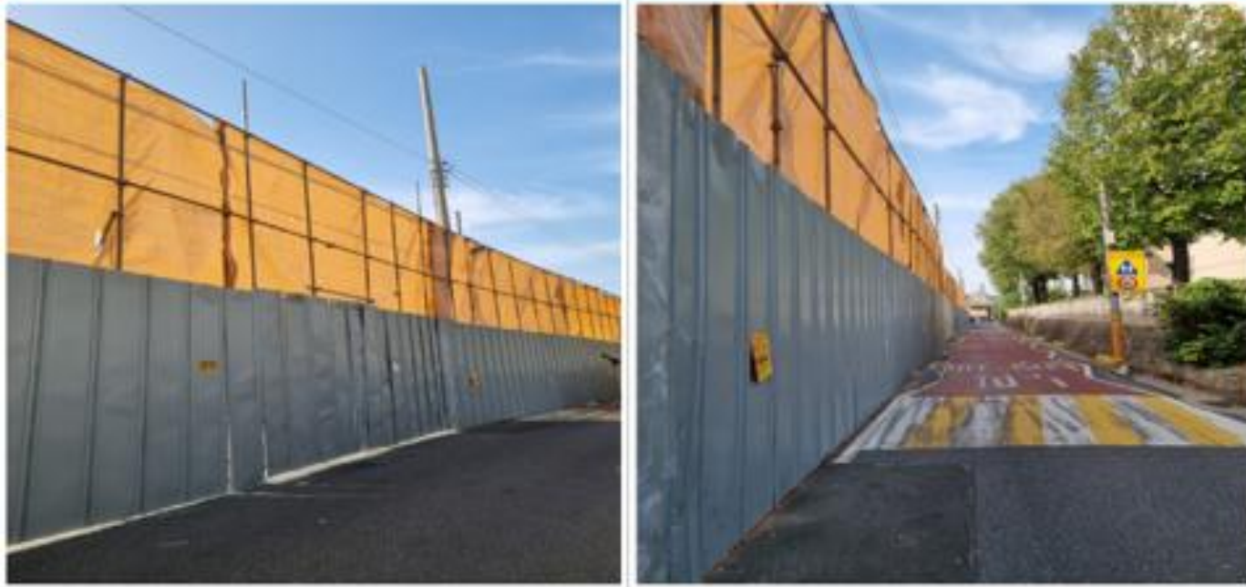
대전 문화동 철거관련 비계 공사
