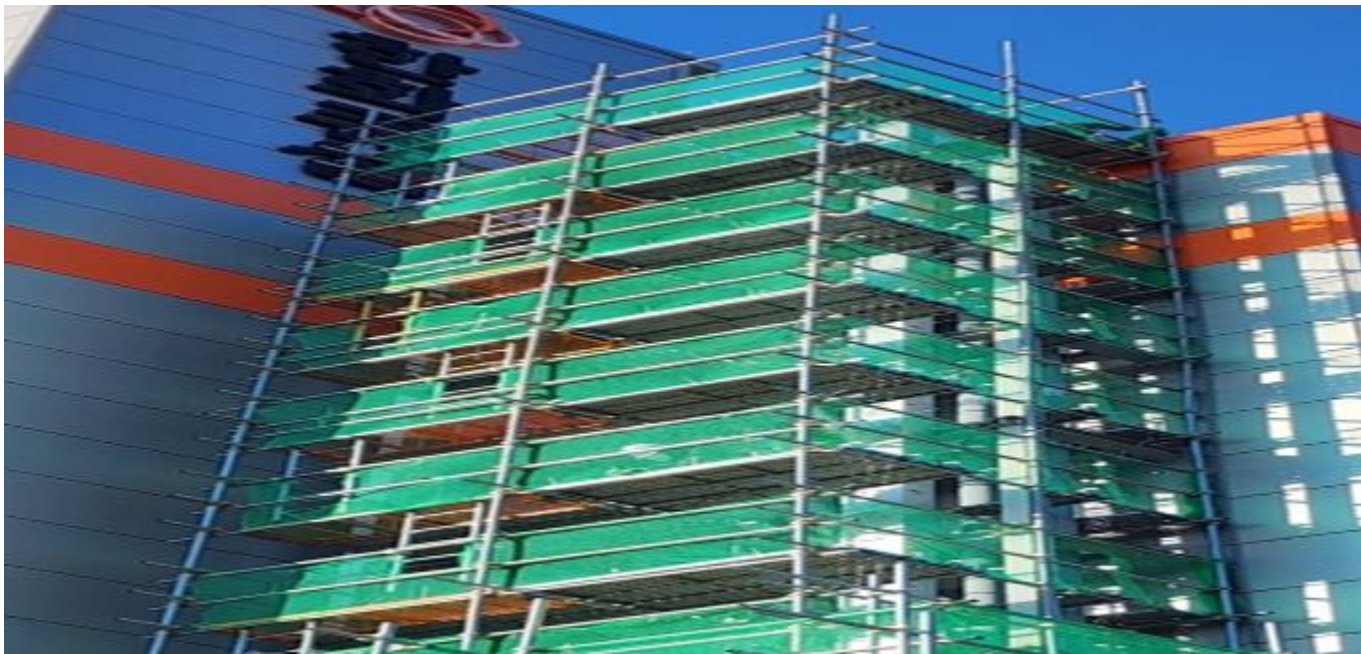
충남 아산 공장 외부 강관 비계 공사
