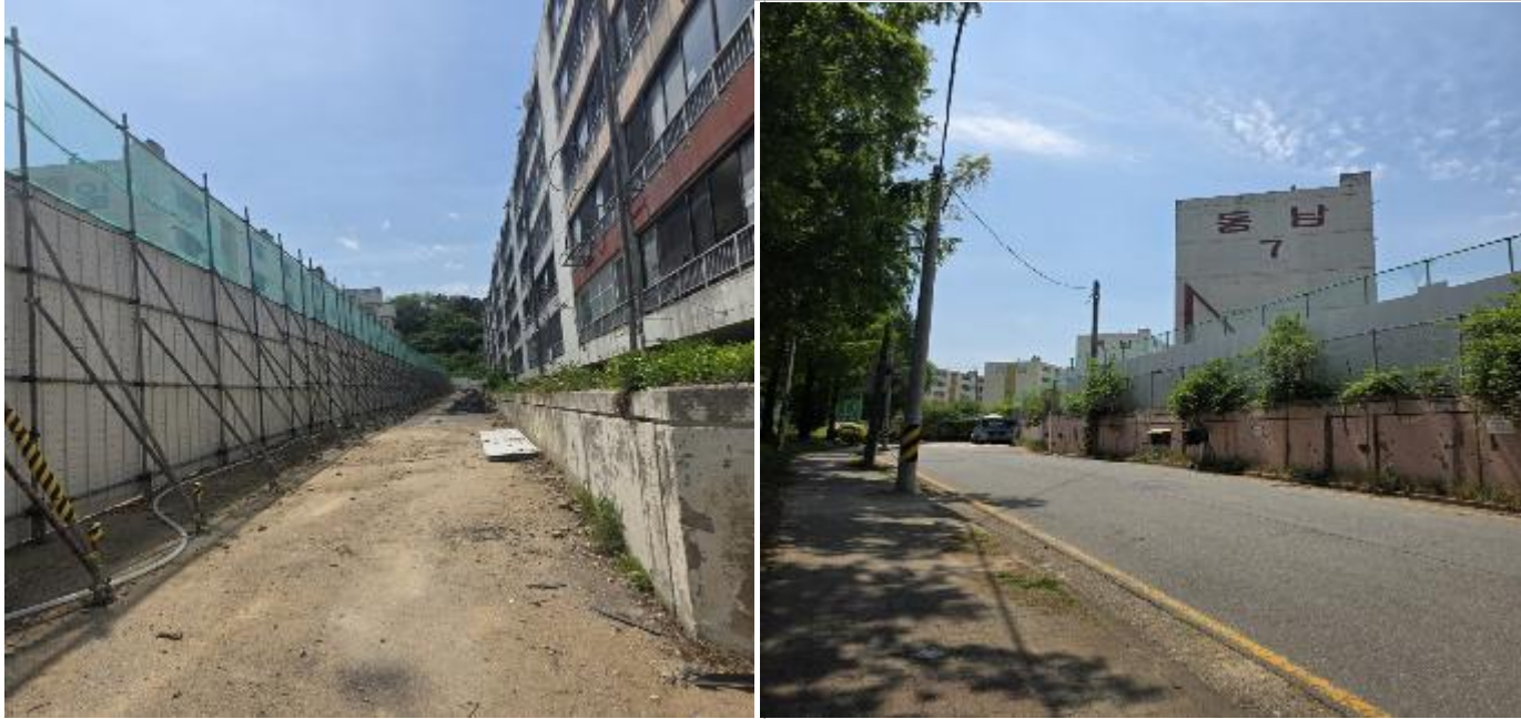
수원 권선구 서둔동 동남아파트 외곽 RPP공사
