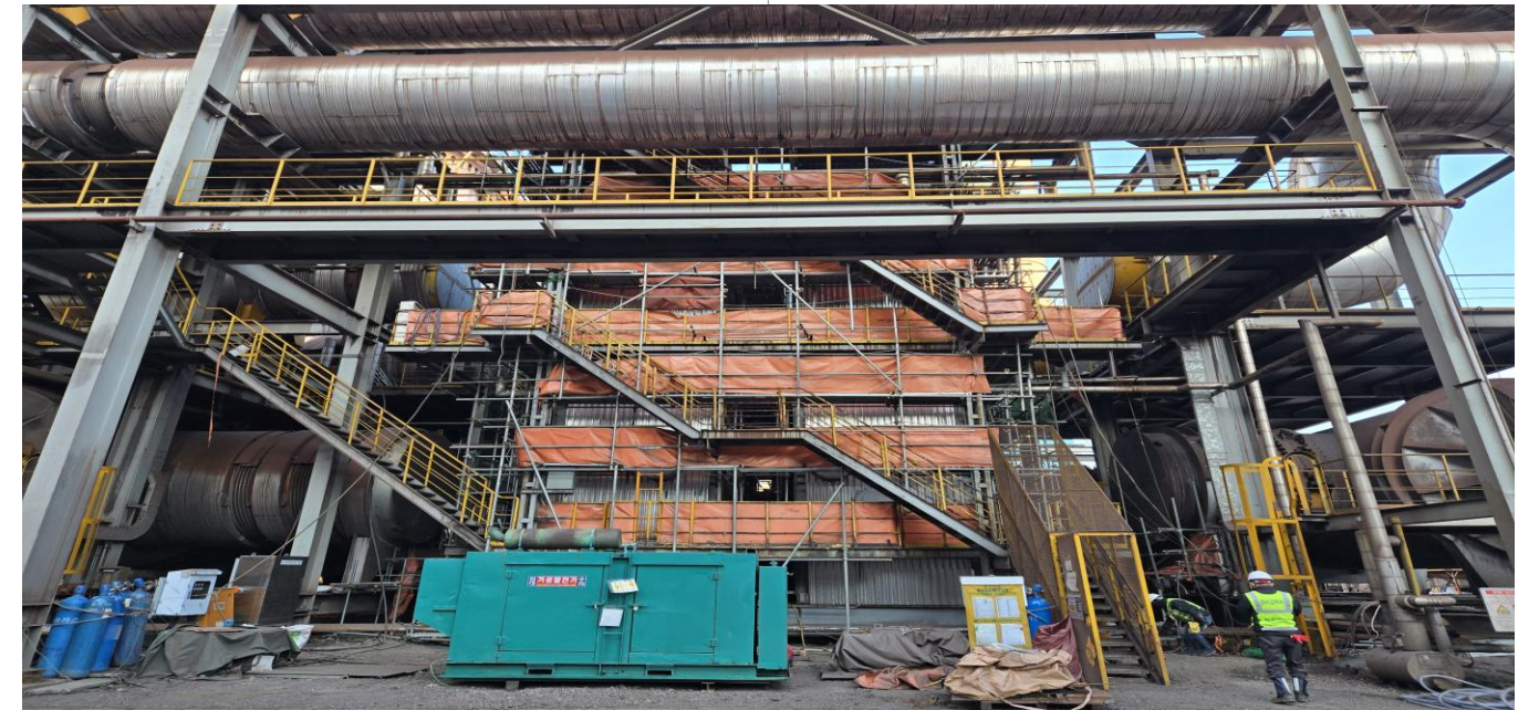
당진 현대제철 탱크교환 공사
