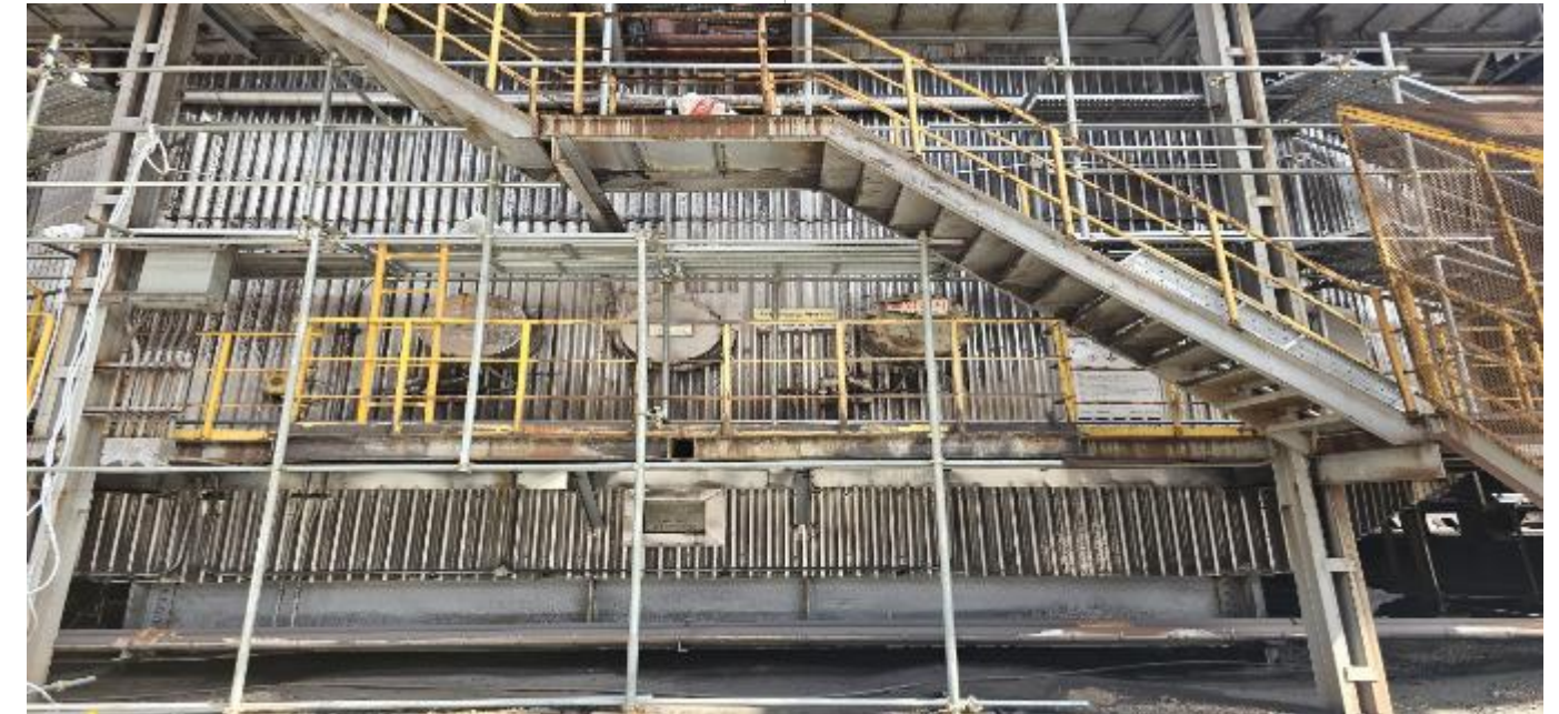
현대제철 발전소 공사
