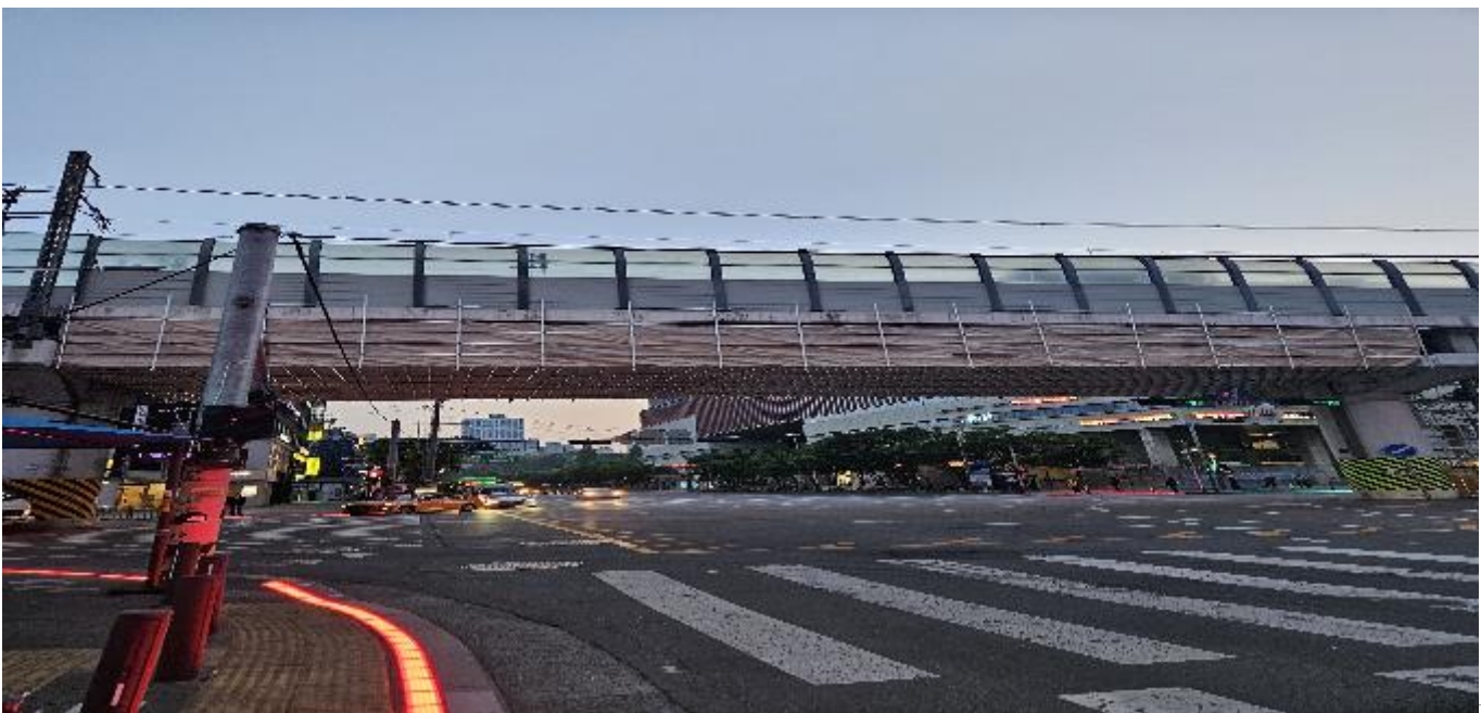
서울 건국대학교 전철역 보수 공사
