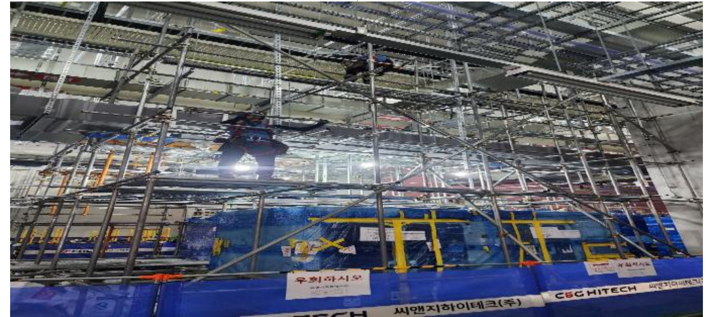
SK하이닉스 반도체 공사
