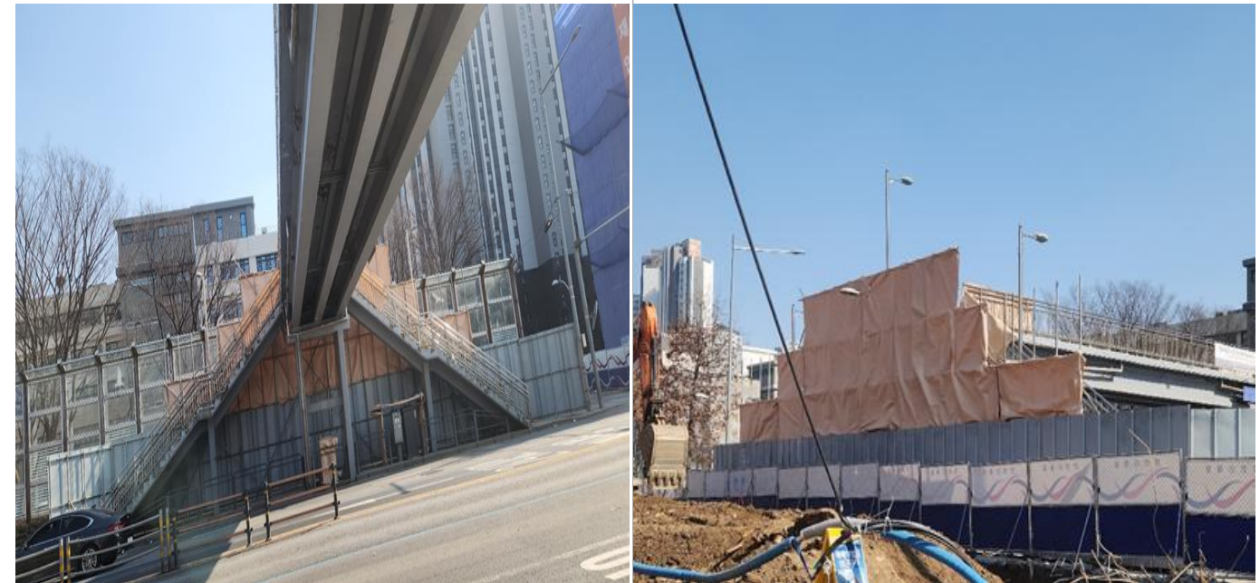
반포 힐스테이트 육교 해체 공사
