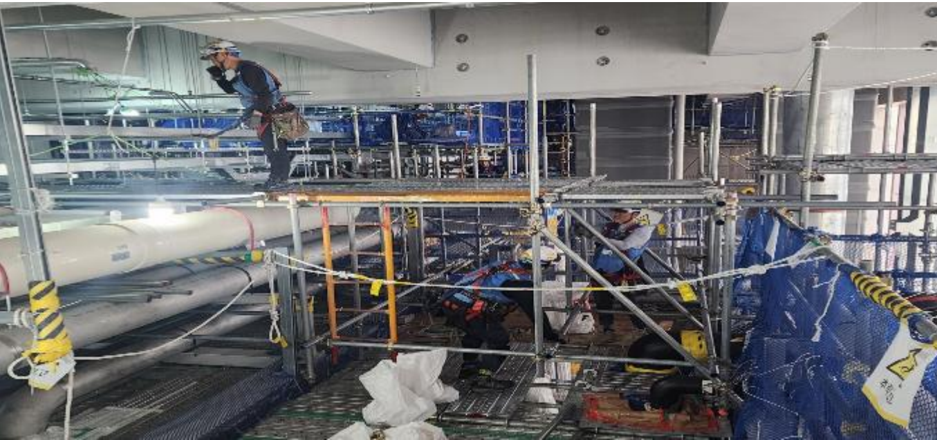
SK하이닉스 반도체 공사
