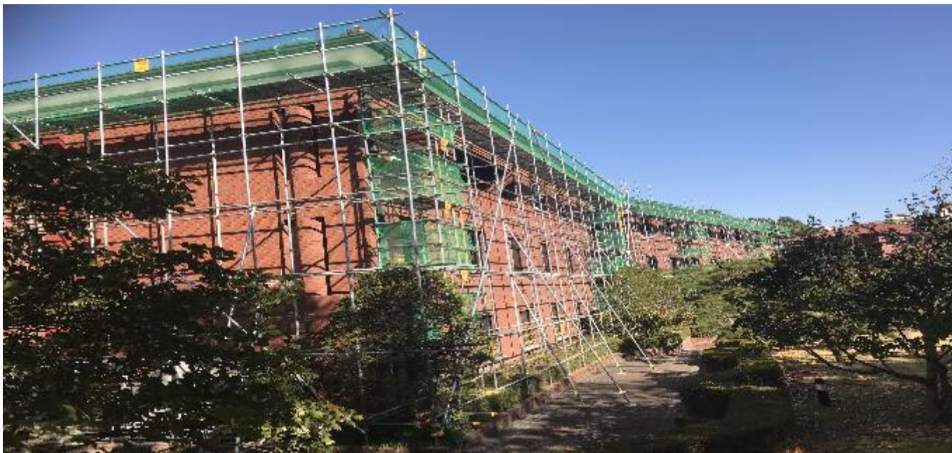
학교 벽체 강관비계 공사
