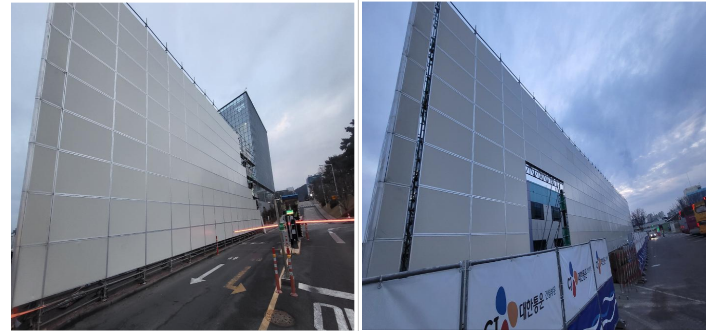
삼성전자 온양캠퍼스 시스템비계 및 매직판넬 공사
