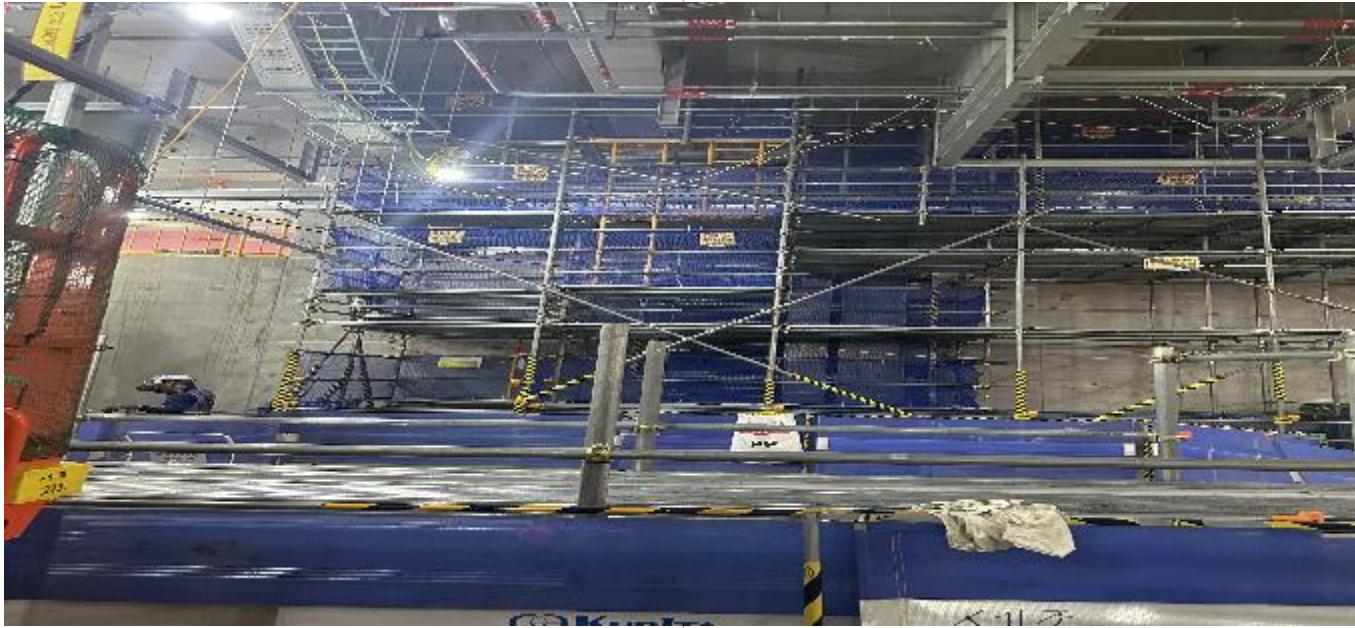
SK하이닉스 반도체 공사
