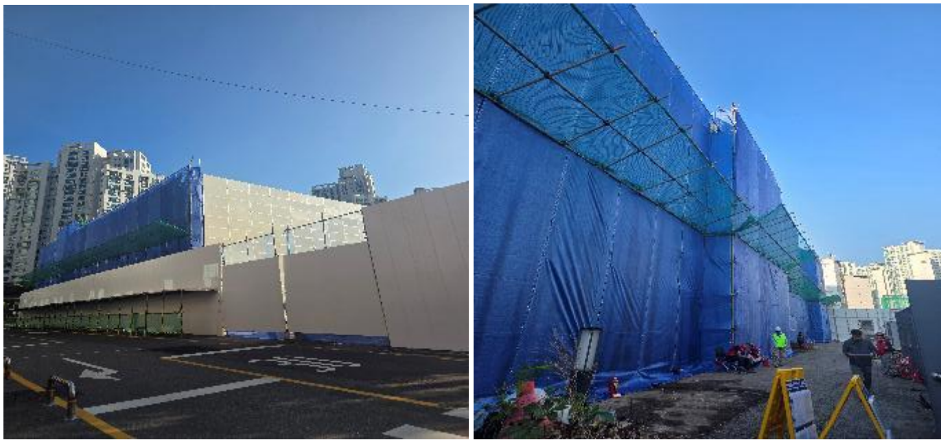
대치동 남서울종합시장 철거관련 매직판넬 및 강관비계 공사
