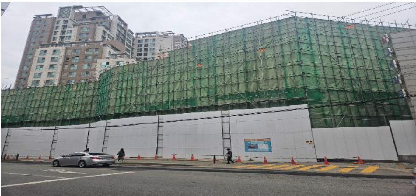
철거 흑석동 철거관련 비계공사
