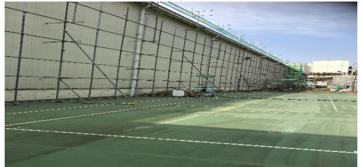
방음벽 설치 공사
