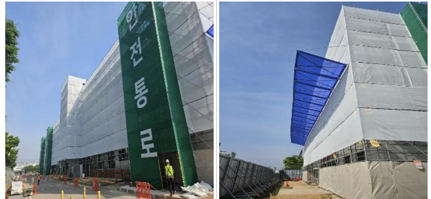
수원 삼성전자 CJ 범진아이앤디 철거관련 비계공사
