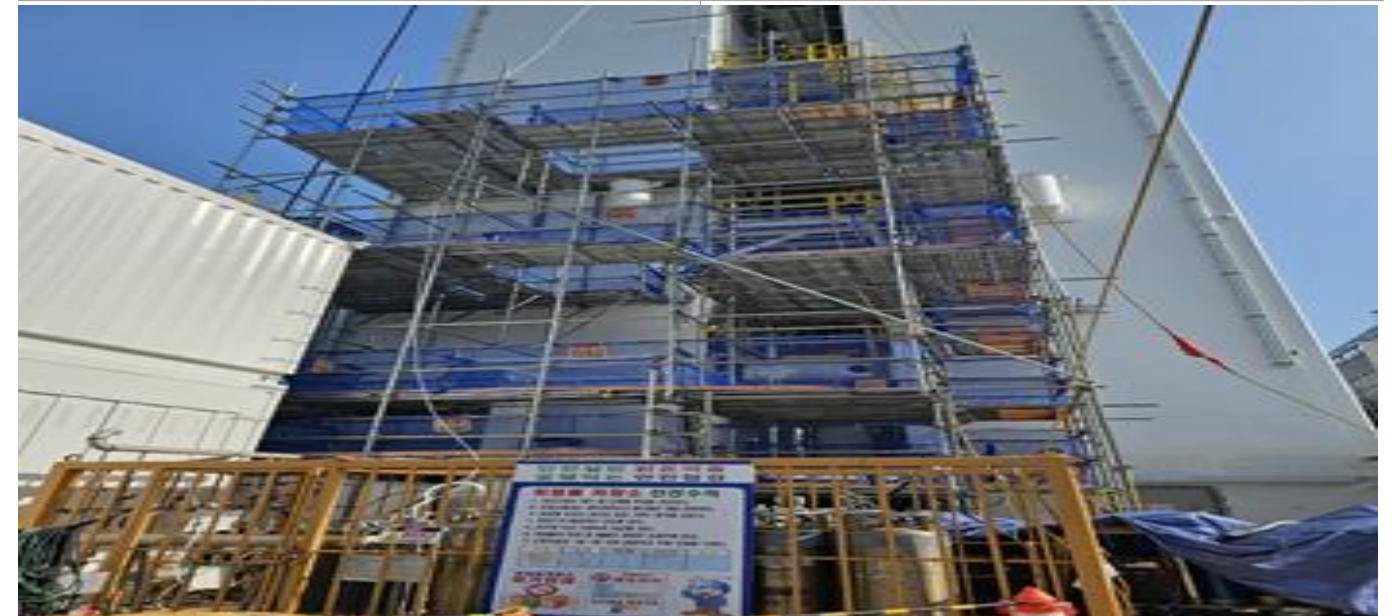
공장 외부 강관 비계 공사
