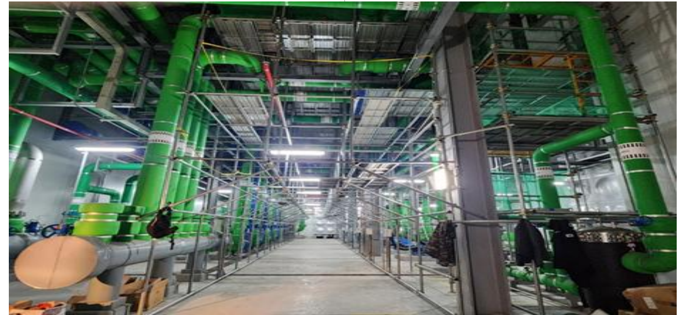
SK하이닉스 비계 공사
