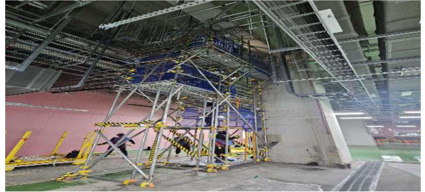
SK하이닉스 반도체 공사
