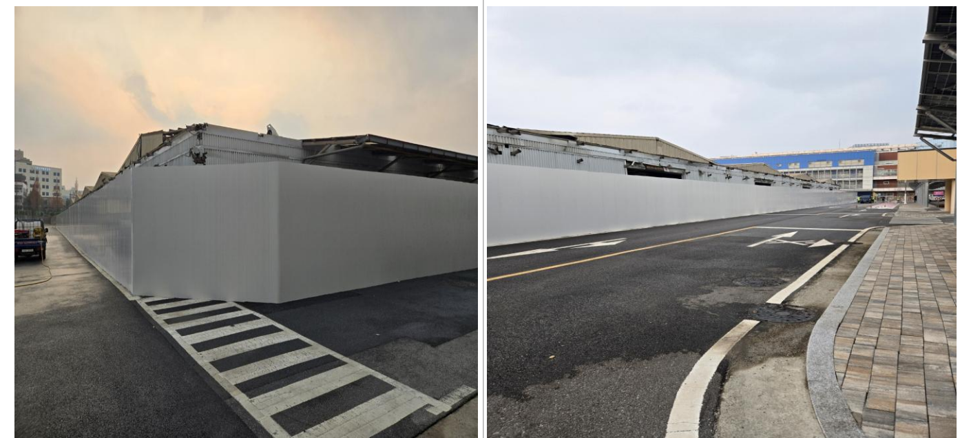
수원 삼성전자 미래동 창고 RPP공사
