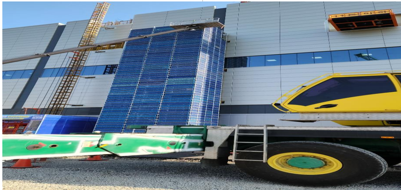
인천 송도 삼성바이오 워킹타워 공사
