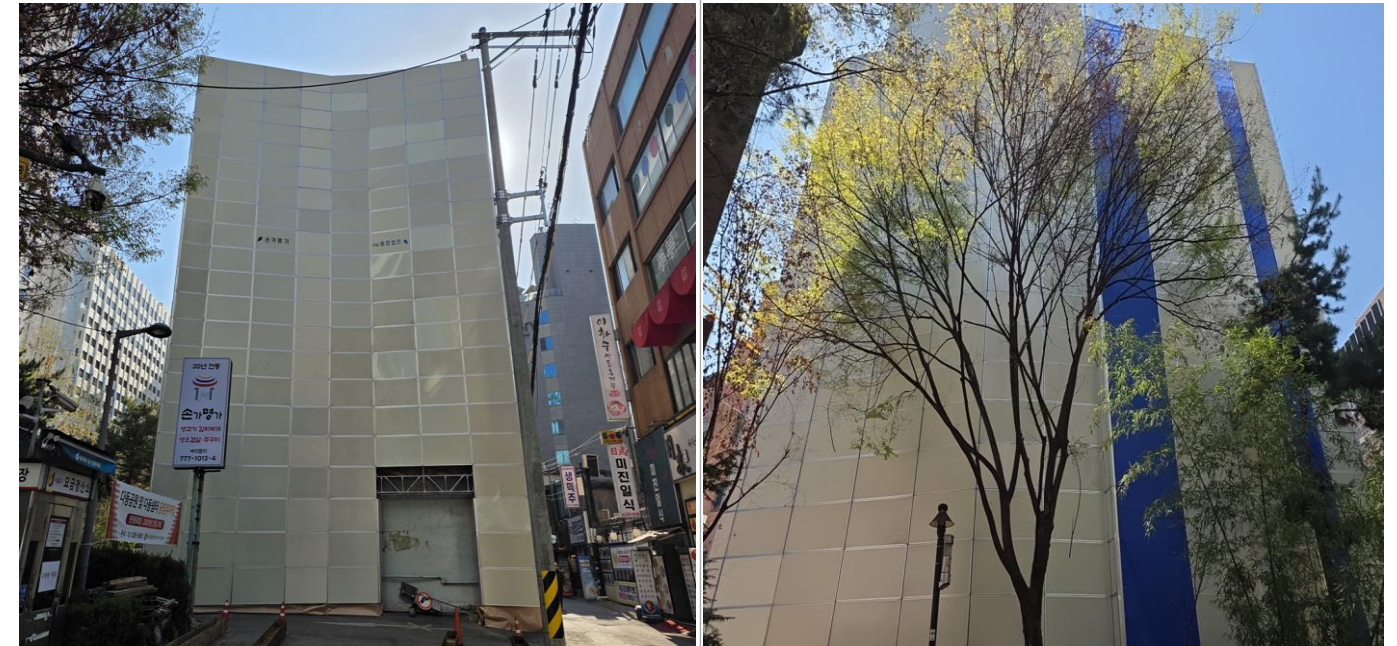
원청 CJ 한수빌딩 해체 공사
