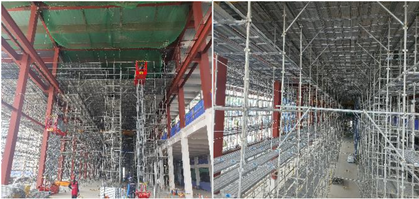
충남 아산 공장 시스템 비계 공사
