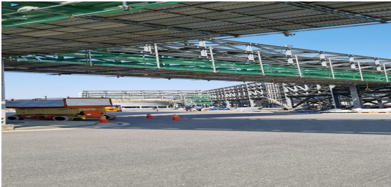
SK하이닉스 달대 비계 공사
