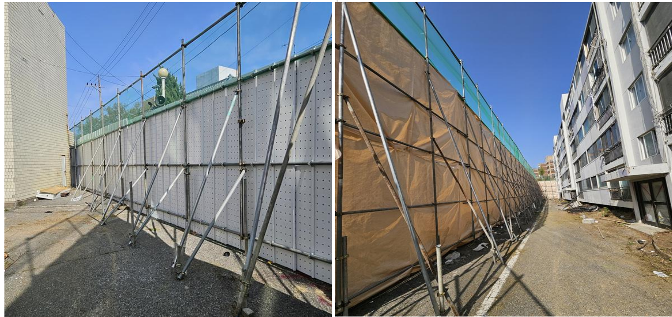
인천 부평 재원아파트 철거 외곽 RPP 공사
