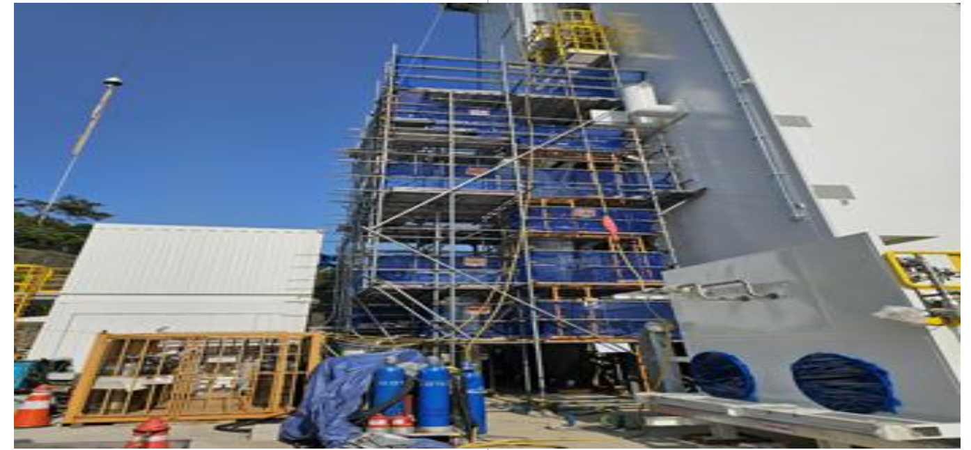
공장 외부 강관 비계 공사
