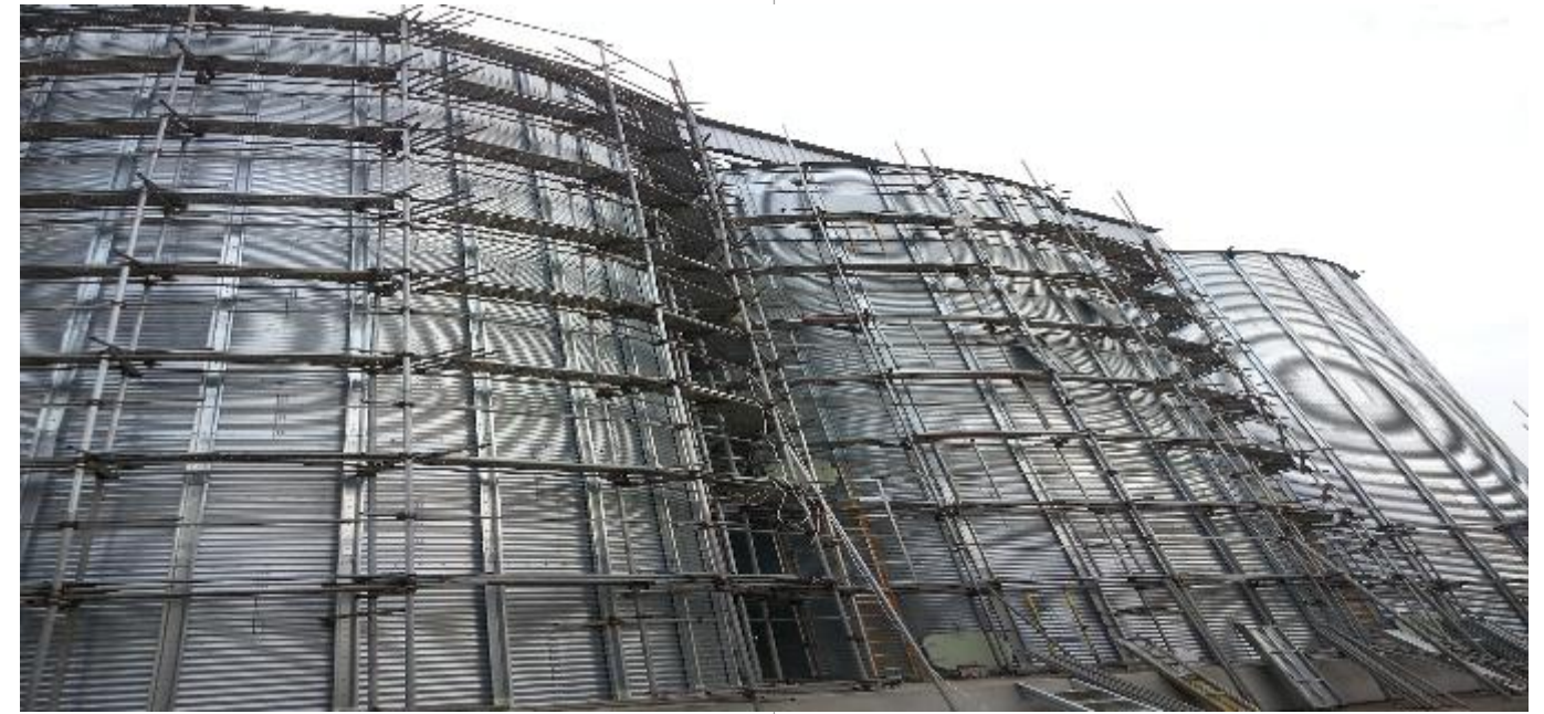
농협 저장창고 강관비계 공사
